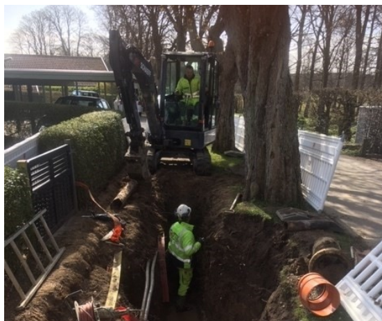
Figur 3. Udskiftning af kloakledning under Voldstien
